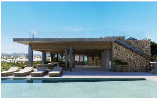
Neubau Projekt Santa Ponsa
