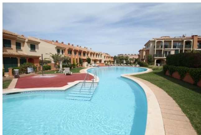
Pool in Wohnanlage El Toro
