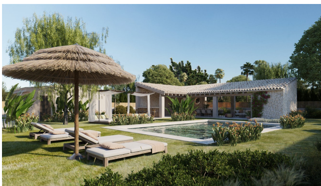
Aussenbereich Pool / in Fertigstellung
