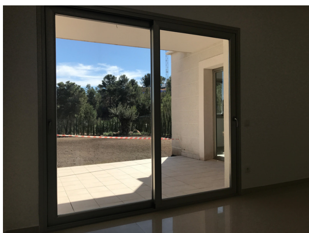
Neues Haus mieten
